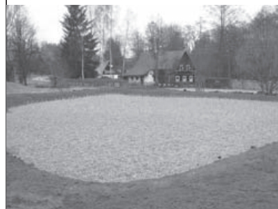
Kořenová čistírna odpadních vod v Srbské Kamenici
