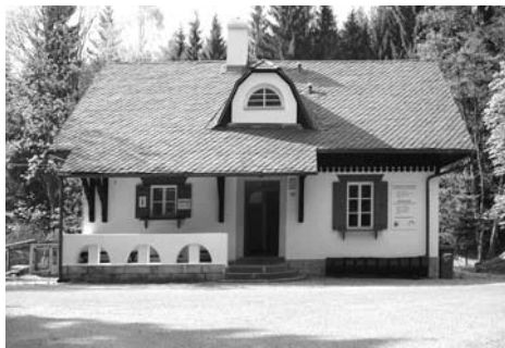
1. Budova IS Dolní Chřibská – Saula
