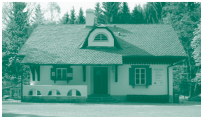
Budova IS Dolní Chřibská – Saula
