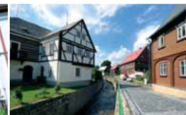
Podstávkové a hrázděné domy ve Chřibské
